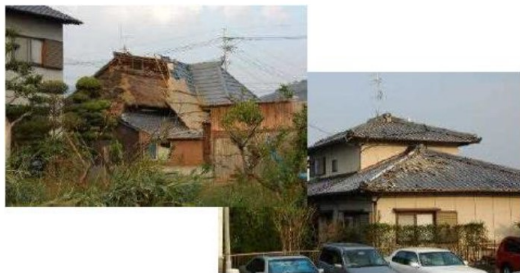
2004年台風23号による建物被害の様子
